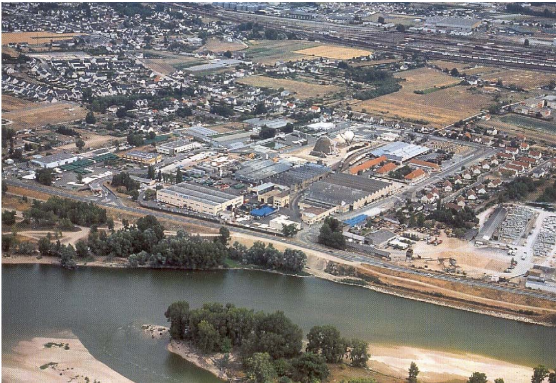
Site de Primagaz à Saint-Pierre-des-Corps
