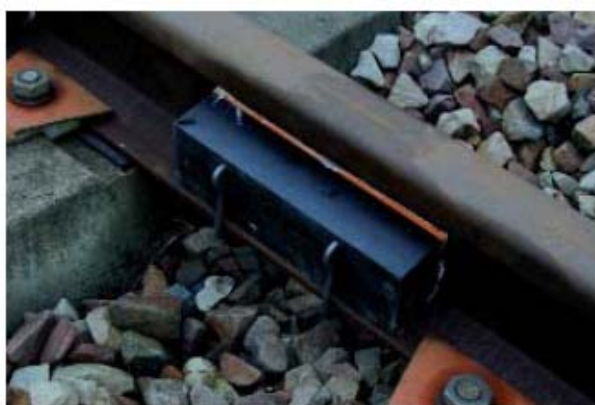
Exemples d'absorbeurs sur rail (Corus et Socitec)
