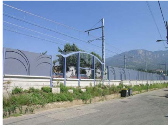
Exemples d'écrans acoustiques à Aix Les Bains
