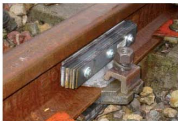
Exemples d'absorbeurs sur rail (Corus et Socitec)
