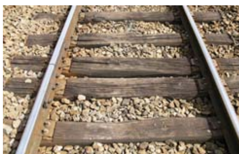
Rails courts sur traverses bois
