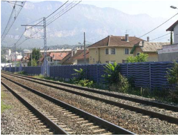
Exemples d'écrans acoustiques à Aix Les Bains
