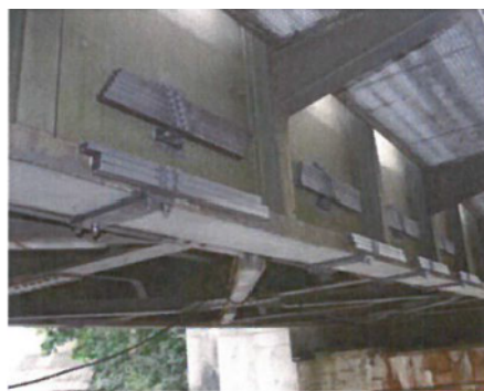
Illustration 8: Absorbeur sur platelage
