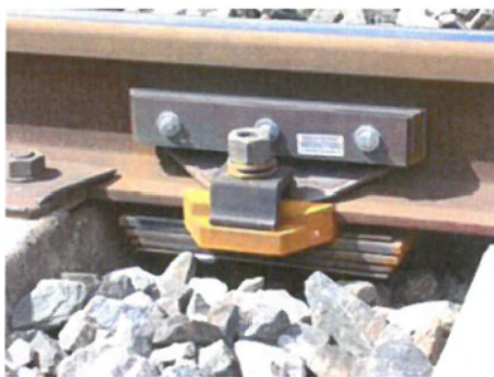
Illustration 9: Absorbeur sur rail
