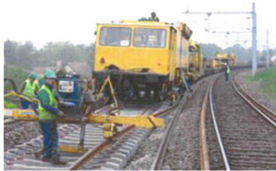
Illustration 4: Longs rails soudés sur traverses béton
