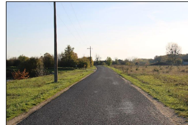
Route départementale RD71 le long du site d'étude
