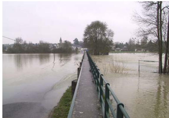
Crue de l'Indre, à Perrusson, janvier 2004
