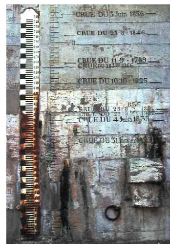
Echelle de crues du pont Wilson à Tours.
