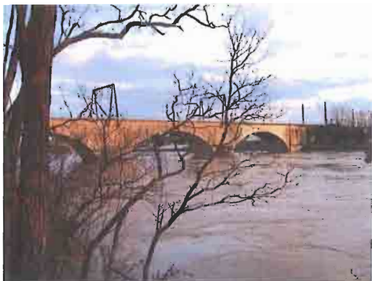
6 mars 2006 la Creuse - La Celle-Saint-Avant - pont SNCF
