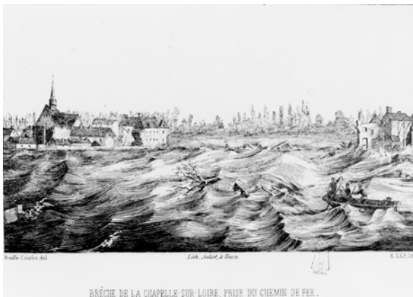
Brèche de La Chapelle-sur-Loire, le 3 juin 1856. Gravures extraites de « Inondations du département d'Indre-et-Loire », de Rouillé-Courbe – 1858 - Bibliothèque de Tours.
