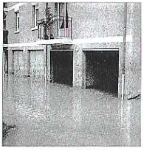
Caves et garages inondés à Rochecorbon. (Photo : F.B.)
