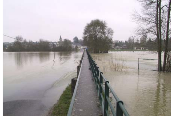
Crue de l'Indre, à Perrusson, janvier 2004
