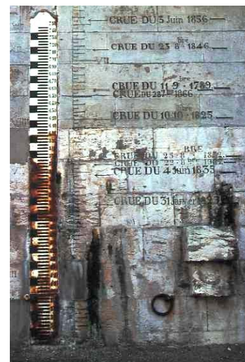
Echelle de crues du pont Wilson à Tours.
