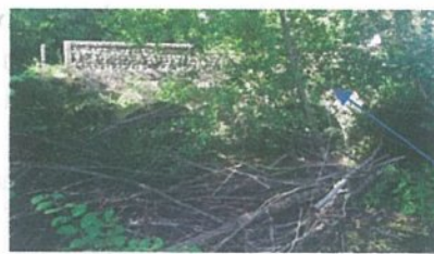
Pont sur la Dême
