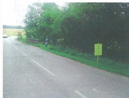
pont entrée Est Epeigné
