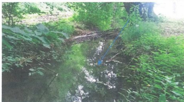
Cours de la Dêmée avant le répartiteur A Noter l'encombrement par racines
