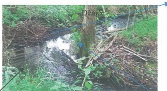
passage à gué par pylônes au déversoir
