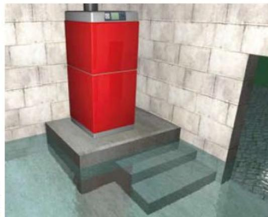
Protection d'un équipement de chauffage par surélévation.
