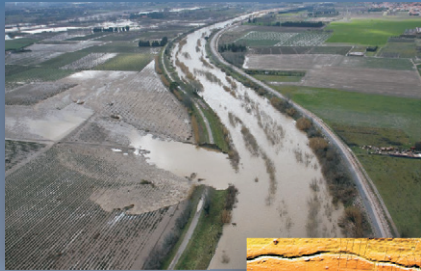
Ex. Brèche digue de l'Agly, 66 (photo DREAL LR)
